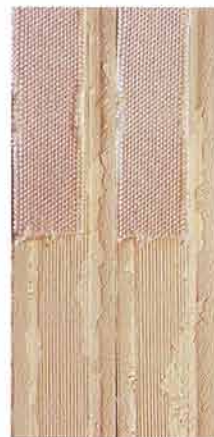
加水分解による劣化
